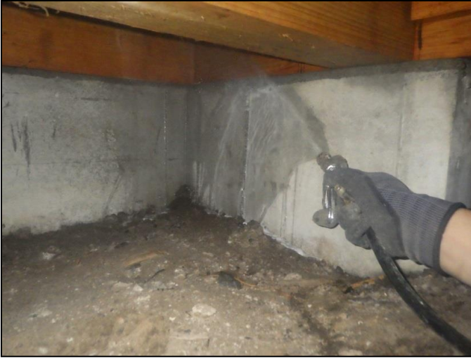
既設防蟻工事 床下地面及び配管立ち上がり薬剤散布
