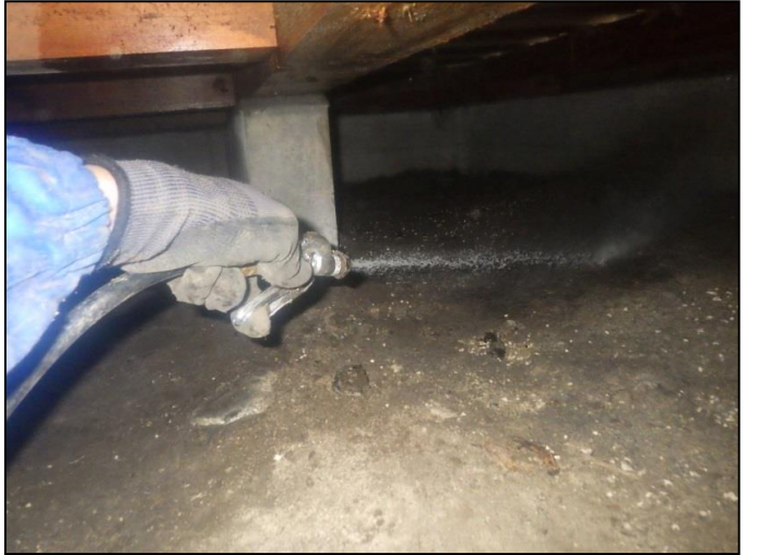
既設防蟻工事 床下地面及び基礎立ち上がり薬剤散布
