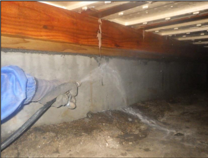
既設防蟻工事 床下地面及び配管立ち上がり薬剤散布
